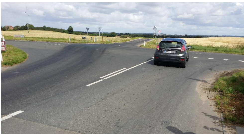
Figur 6-4 Krydset Merløsevej/Nyrupvej set fra syd. Det er muligt fra nord at køre direkte gennem krydset uden ophold. Korrekt kørsel mod nord kræver lavere hastighed pga. forskydningen.
