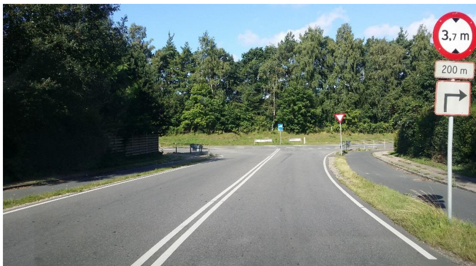
Figur 7-12 Kryds Skælskørvej/Næstvedvej oversigtsproblemet skyldes hegnet til venstre i billedet.
