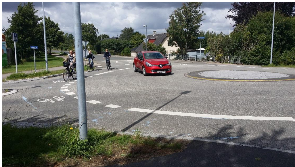
Figur 7-14 Mange skolebørn føler sig utrygge i rundkørslen Rustkammervej/Katrinelystvej. Rundkørslen har tidligere været udpeget pga. ulykker, men den er ikke udpeget i perioden 2011-2015. Rundkørsel er til gengæld udpeget pga. utryghed. Se 6.2.9 på side 33.
