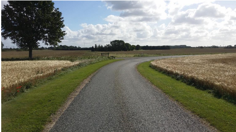
Figur 7-10 Skelbækvej set mod øst. I ydersiden af kurven er der en grøft.
