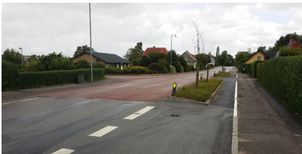
Figur 6-8 Hovedgaden i Stenlille ved Fasanvej. I 2016 er der etableret rød flade for at øge bilisternes opmærksomhed. Ved besigtigelsen var afstribsningen ikke udført.
