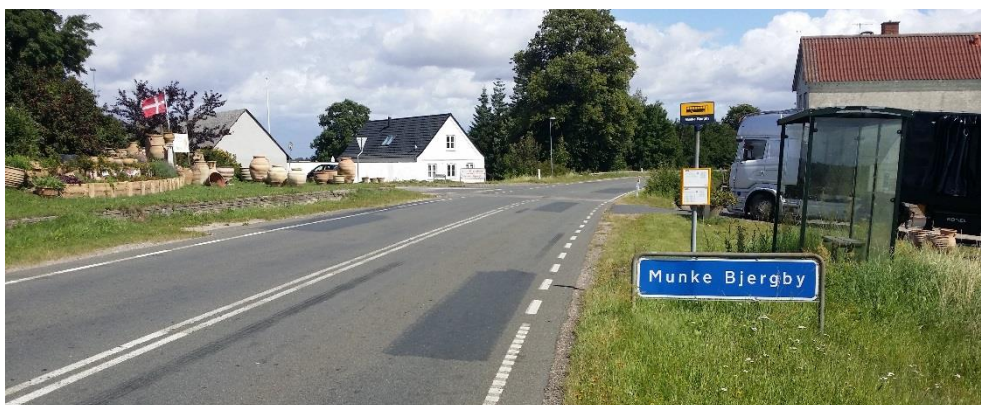
Figur 7-6 Munkebjergbyvej ved Kirkebakken.
